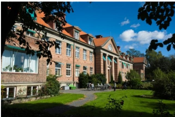
Hovedbygget på Vinderen (Bygg A) er fra 1930 og fasaden er vernet.
